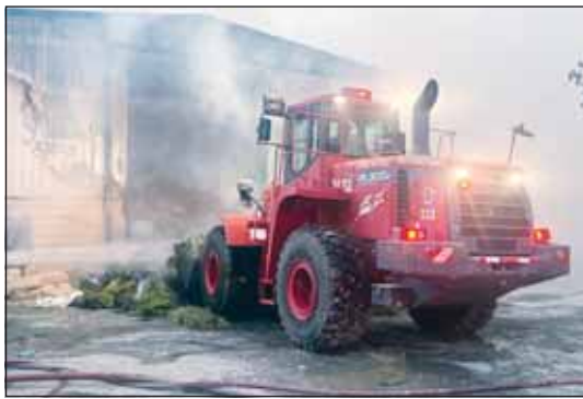
استخدام الجرافات لإزالة الحطام وفتح الطريق لآليات الإطفاء
