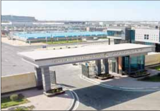
محطة مياه بحر البقر. أحد مشاريع الصندوق في مصر
