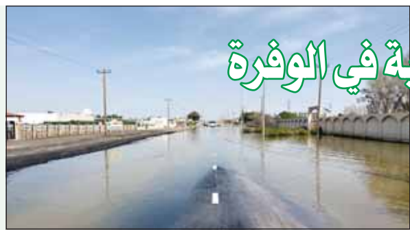
المياه تغطي الطرق
