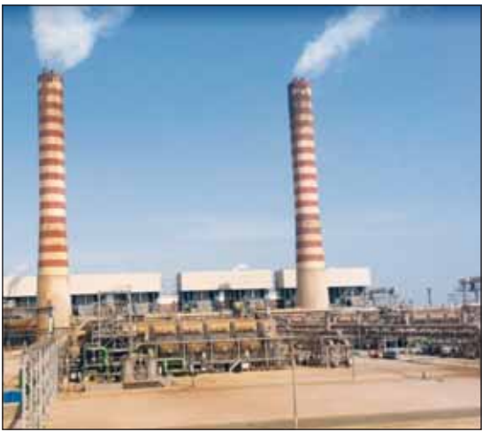
محطة الزور الجنوبية
