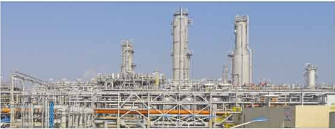
خط الغاز المسال الخامس بمصفاة ميناء الأحمد
