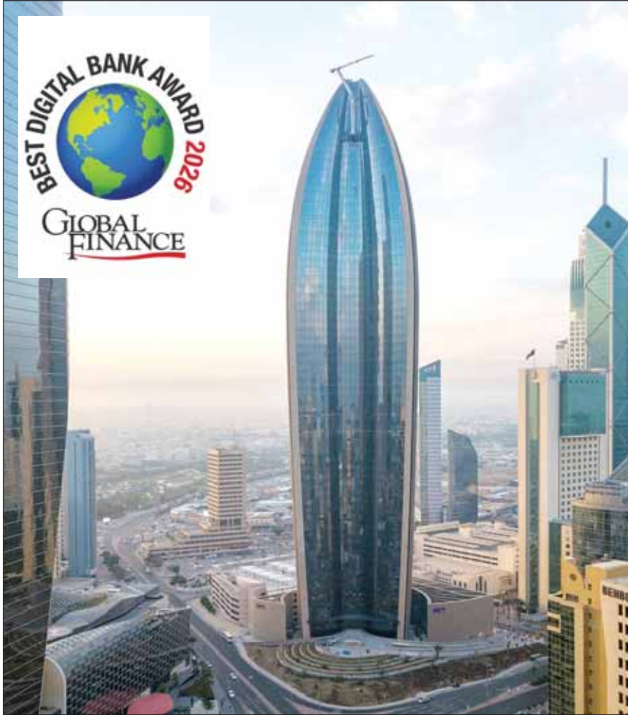
المبنى الرئيسي لبنك الكويت الوطني
