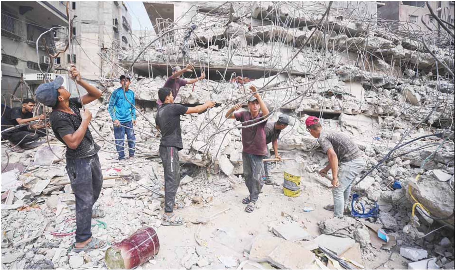
فلسطينيون يستخرجون الحديد من أنقاض المباني التي دمرها الاحتلال الإسرائيلي في مدينة غزة لإصلاح وإعادة تنويره واستخدامه في البناء أو نصب الخيام أو بيعه (أب)
