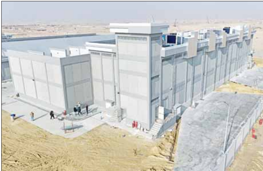
محطة تحويل كهرباء رئيسية
