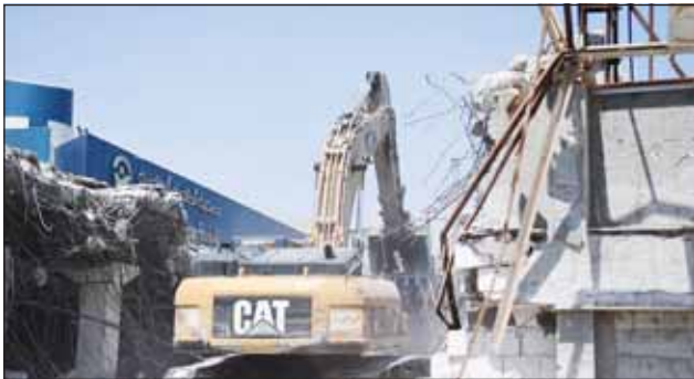
العمل جارٍ للانتهاء قريباً من هدم المبنى القديم
